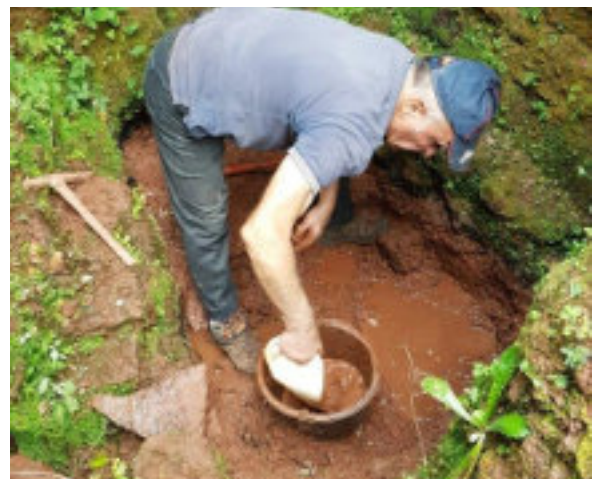
Le puits au début du déblaiement
