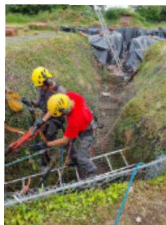
Althesis en travaux - sécurisation entrée du souterrain
